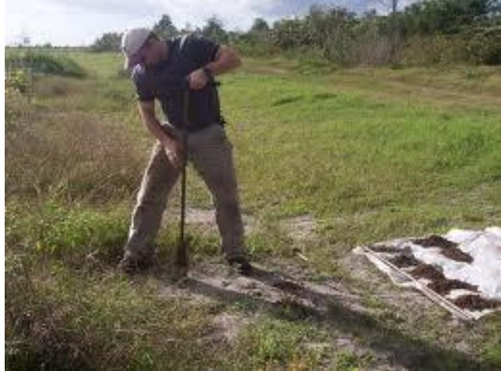
*Se pueden construir pozos de agua poco profundos de pequeña capacidad usando equipos manuales de perforación tales como el taladro eléctrico a la izquierda o una barrena manual a la derecha.*
