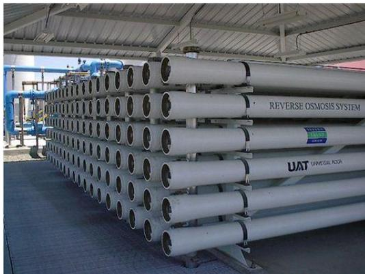
Un típico módulo de fibra hueca puede estar conformado de varios cientos y hasta más de diez mil membranas, tales como las que aparecen en esta matriz de membranas industriales para el tratamiento de aguas residuales.
