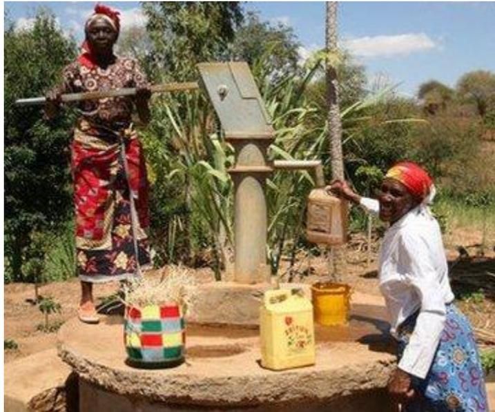
*Una base de concreto y cabezal de pozo elevado previenen la entrada de contaminantes y detrito en el pozo. Las bombas manuales extraen el agua mucho más rápido que el método de cubo y sog a en una polea.*
